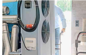
Ihre Unterkonstruktion macht die mobile Wärmepumpe baustellengängig auch auf herausforderndem Untergrund.
